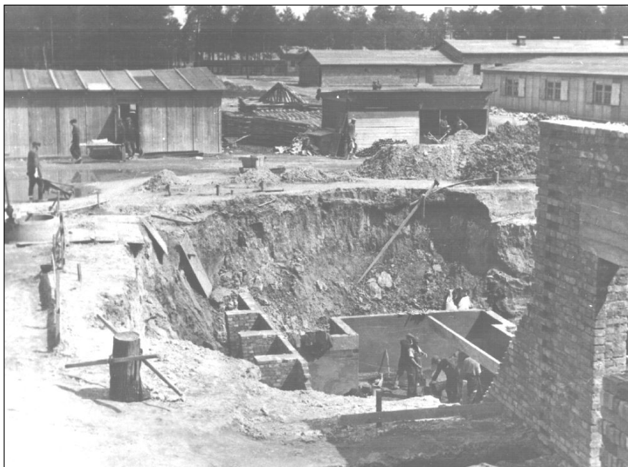
Bild 3: Ausgrabungen für das Fundament der Zentralsauna im Mai 1943
